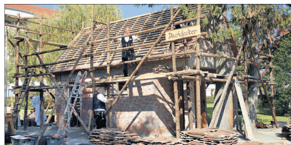
Altes Handwerk in Aktion beim Renovieren des ehemaligen Leichenhauses
